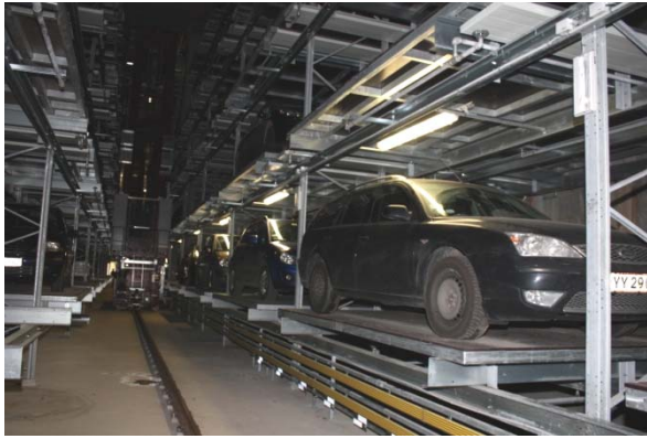
Foto 3: Bajo tierra: dentro del segundo garaje de aparcamiento completamente automatizado de Copenhage.
