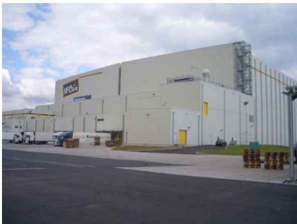
< El almacén de McCain en Harnes, Francia.
